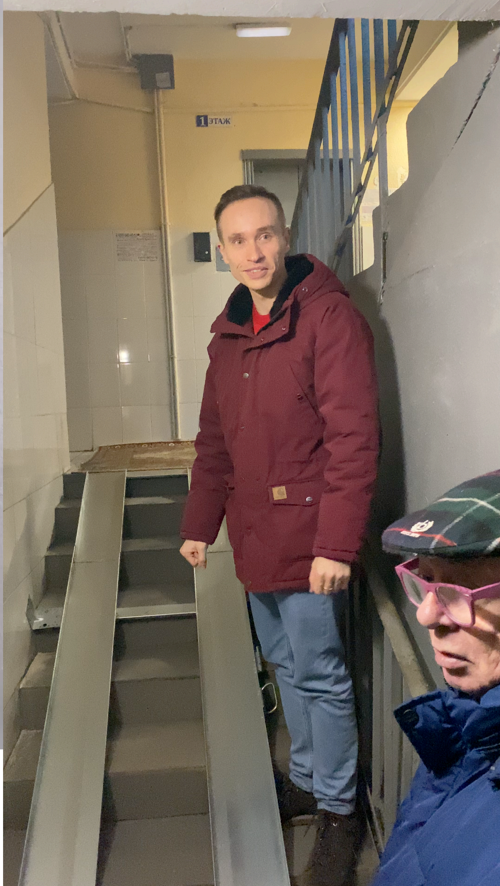
Установлен пандус в подъезде по просьбе местных жителей
